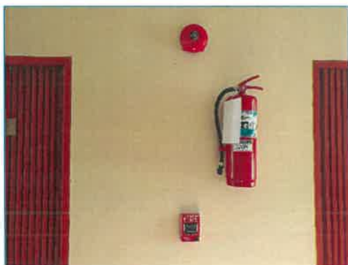
ถังดับเพลิงและระบบแจ้งเตือน
