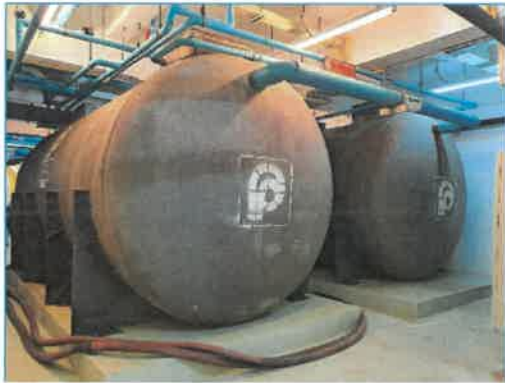
ระบบบำบัดน้ำเสียชนิดเดิมอากาศ
